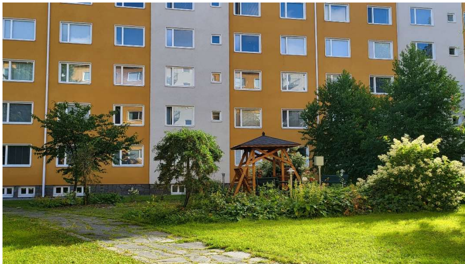
Kuva 5 Sisäpihaa ja julkisivua
